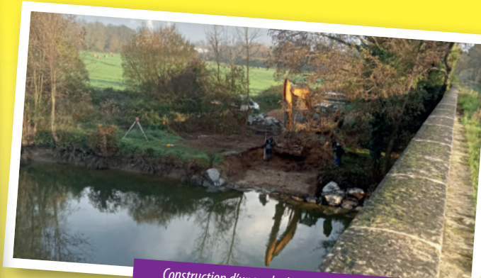
Construction d'une cale de mise à l'eau - Pont de Varennes
